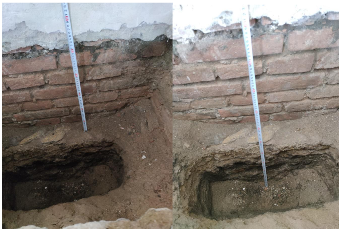
Pohled na kopanou sondu podél obvodové zdi
