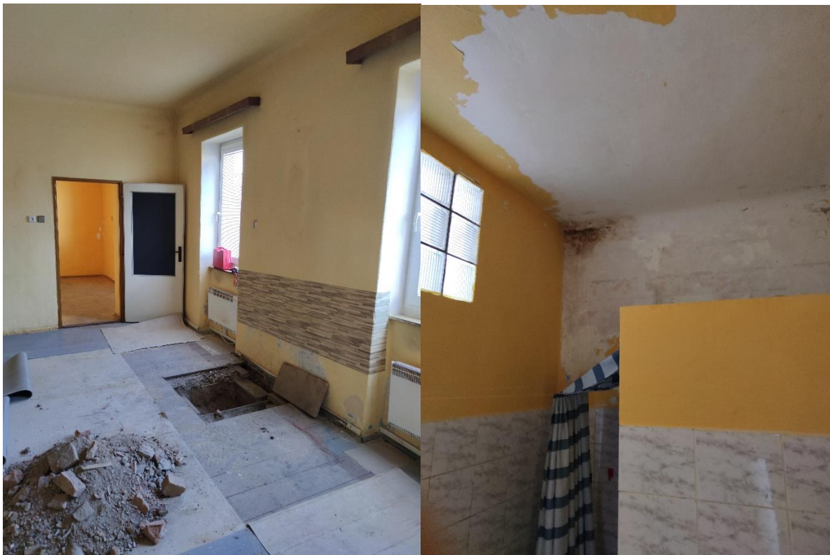
Prostory bytů 2NP, patrné zatékání v místě koupelny jednoho z bytů
