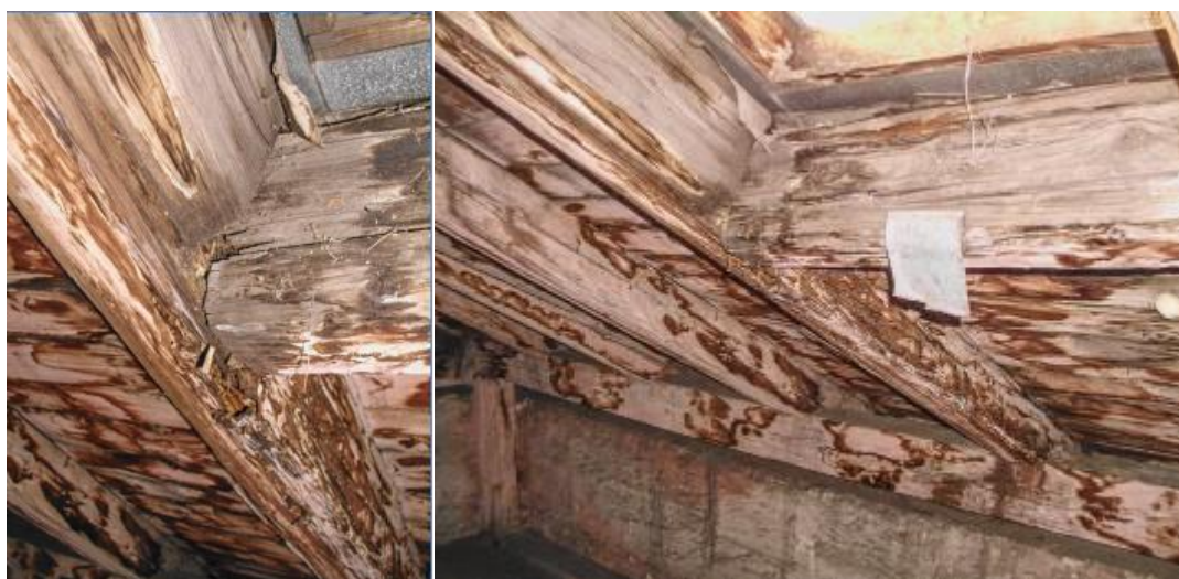
Havarijní biotická destrukce krokve a pozednice (odběr vzorku VZ2)
