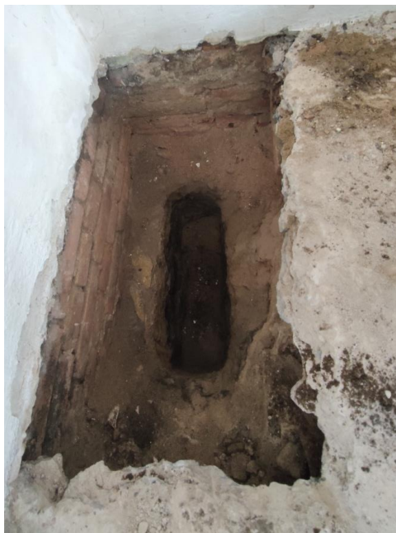
Pohled na kopanou sondu podél vnitřní zdi
