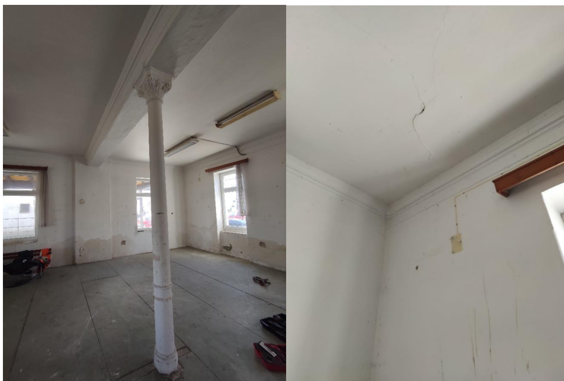
Prostor bývalé čekárny s trhlinami ve stropní desce
