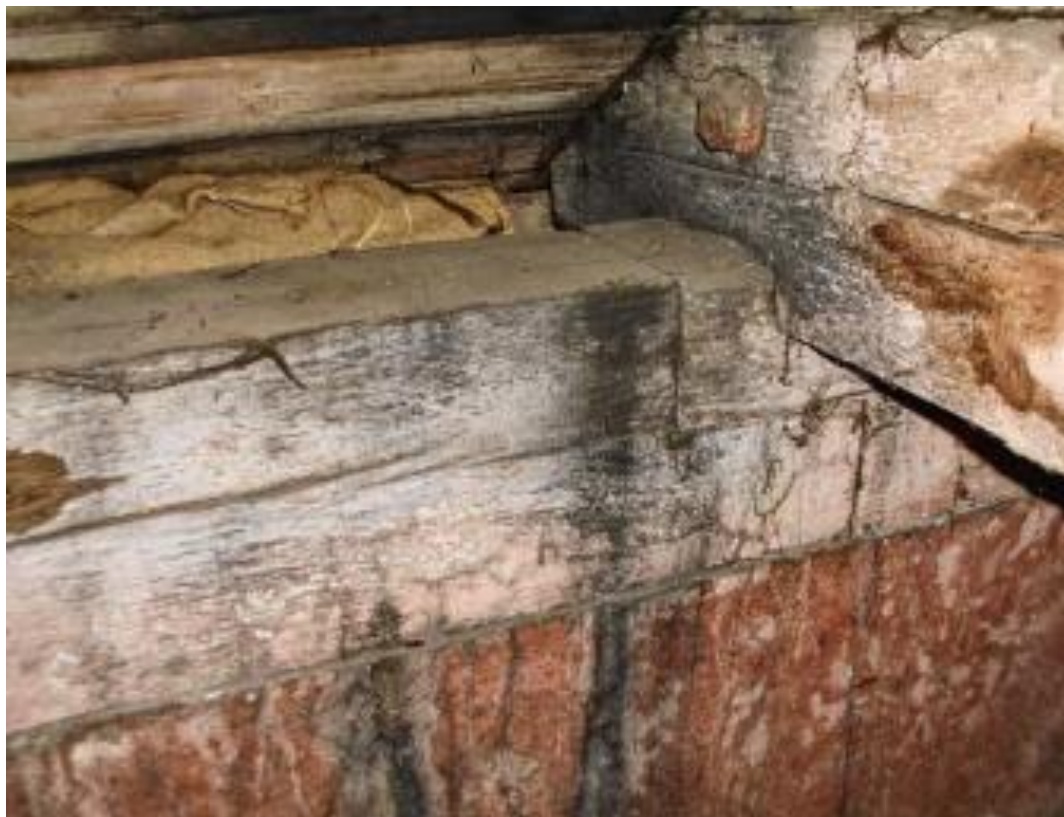
Detail styku pozednice se spodní kleštinou (odběr vzorku VZ1)
