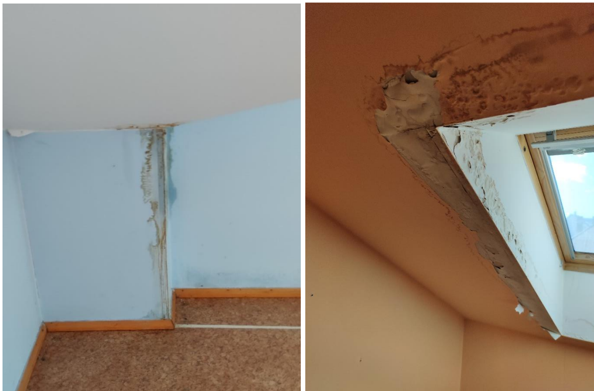
Lokální místa zatékání v prostoru půdního bytu
